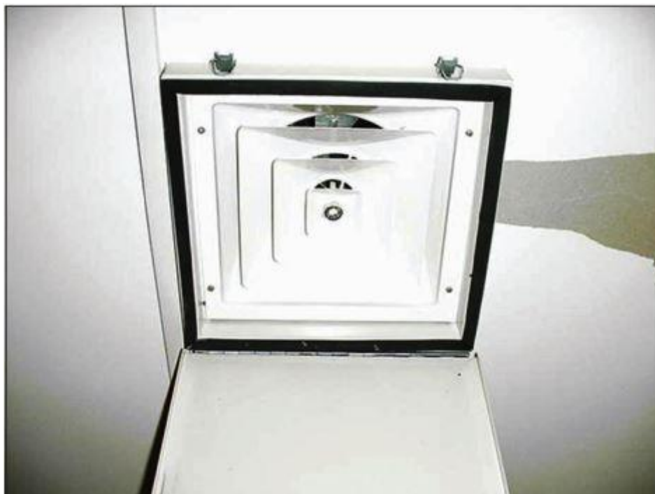
شکل ۶-۰. یک پوشش لولایی برای آب بندی دریچه تامین یک پناهگاه
